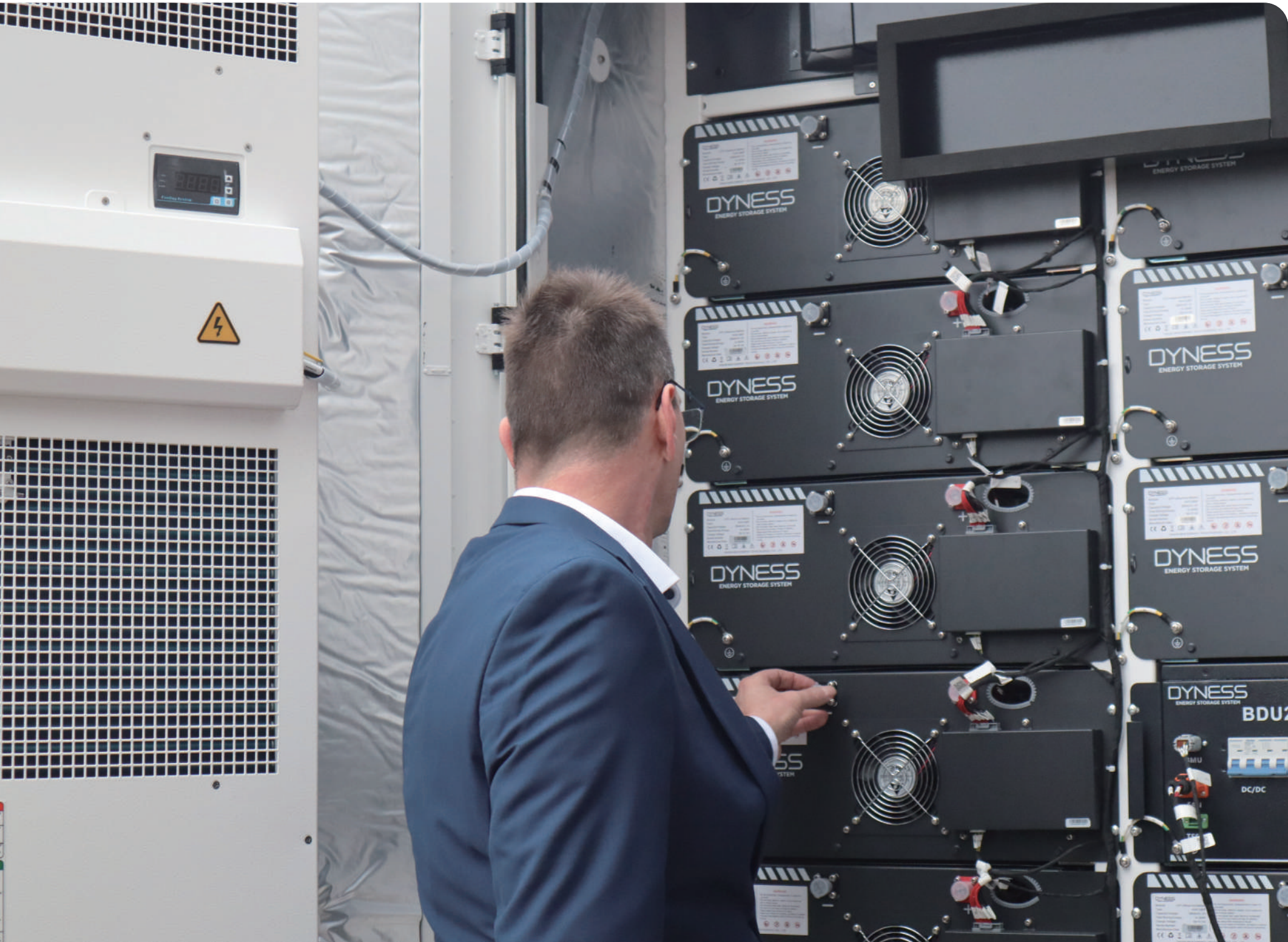
• Niederlande DH200F 100kW/215kWh Dynamische Kapazitätserweiterung + PV-Verbrauch
