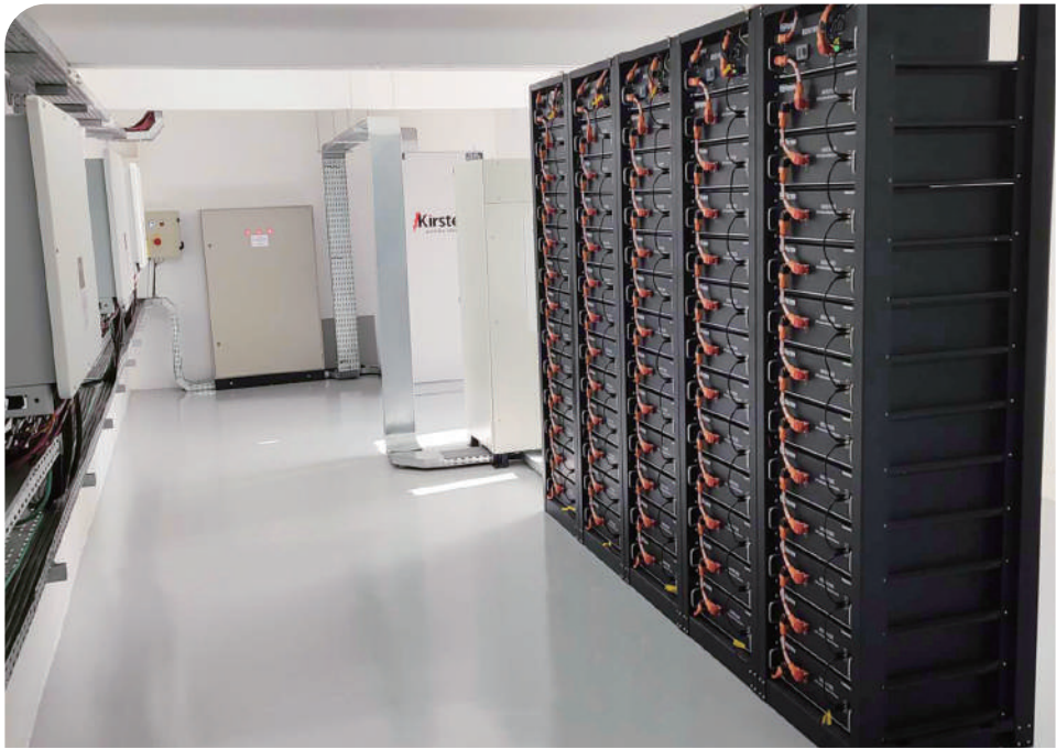
• Brasilien PowerRack HV4 100kW/307kWh Dynamische Kapazitätserweiterung + PV-Verbrauch
